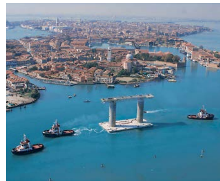
Le strutture di ormeggio vengono rimorchiate da Venezia al terminale GNL Adriatico
