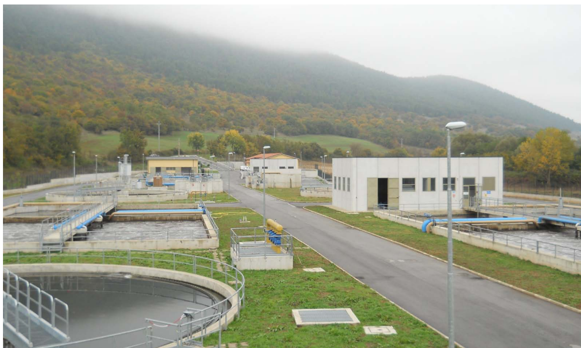
Impianto di depurazione
